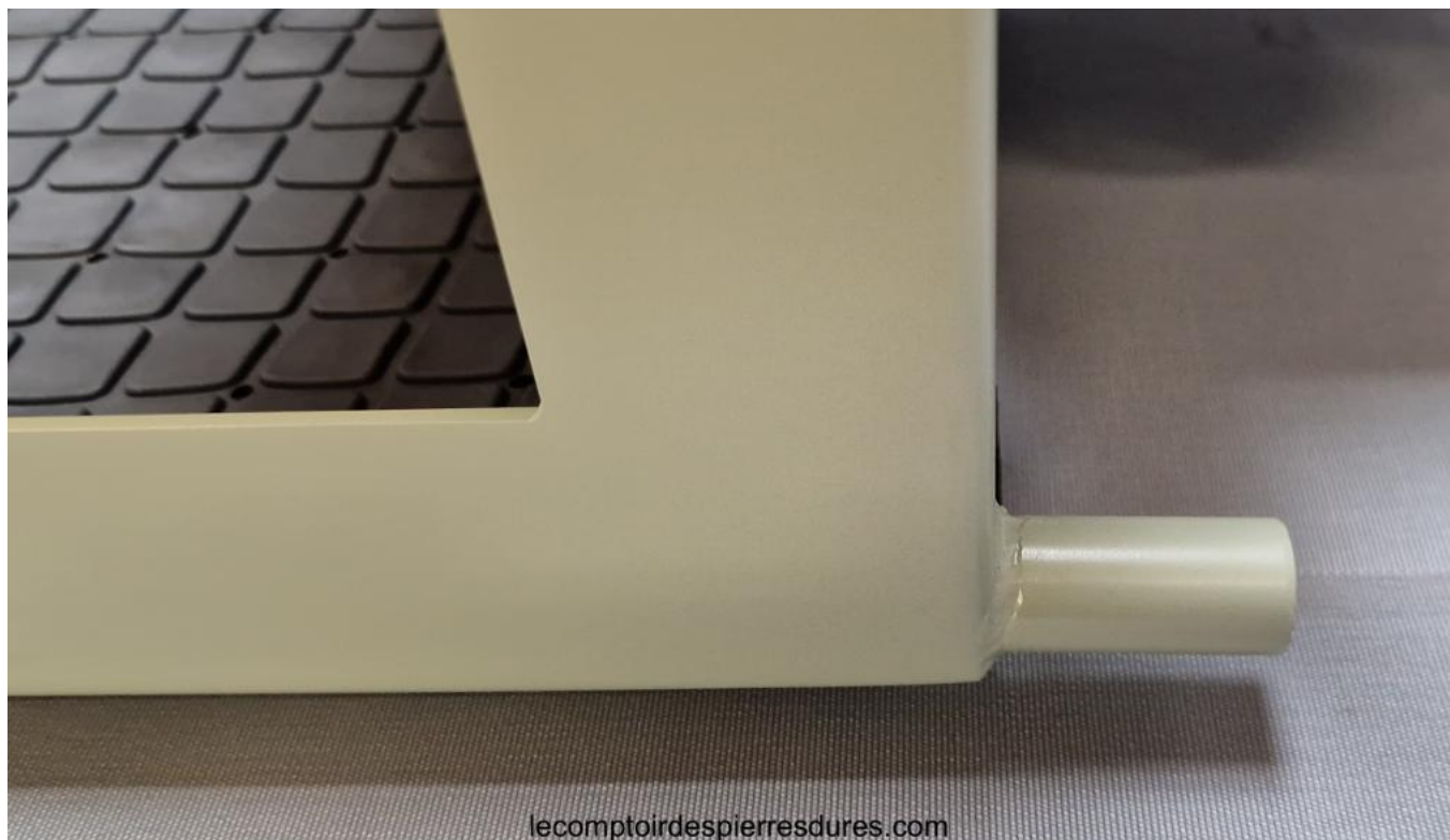
Evacuation de l'eau du bassin
